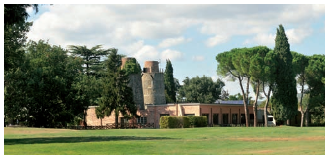
La caratteristica ciminiera sovrasta la Club House
